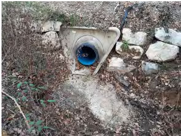
Figure 28 : Photos des différentes traversées de chaussée
