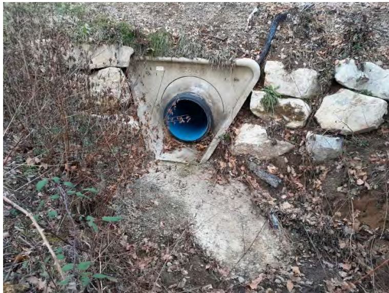
Figure 38 : vue de la tête aval de la traversée de chaussée soutenue par un enrochement sec (ravine 2)
