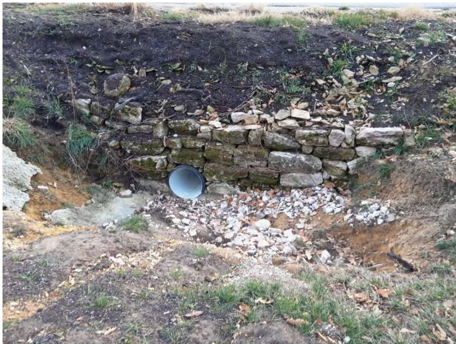
Figure 46 : vue de la tête amont de la traversée de chaussée (ravine 6)
