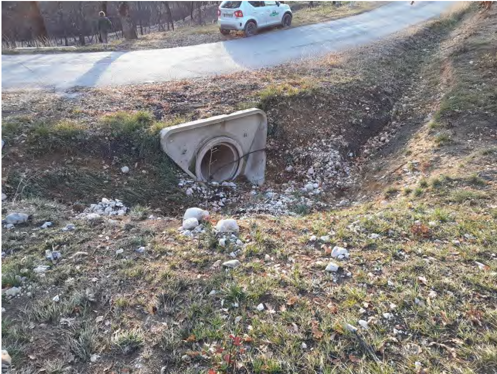
Figure 44 : vue de la tête amont de la traversée de chaussée (ravine 5)
