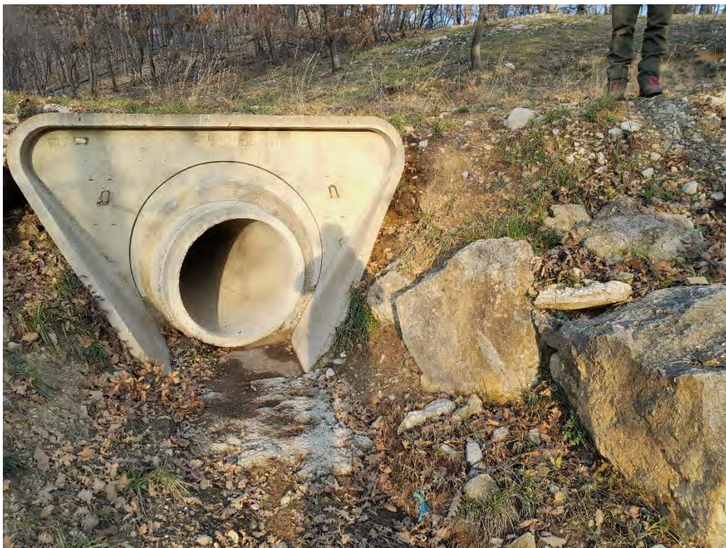
Figure 45 : vue de la tête aval de la traversée de chaussée (ravine 5)
