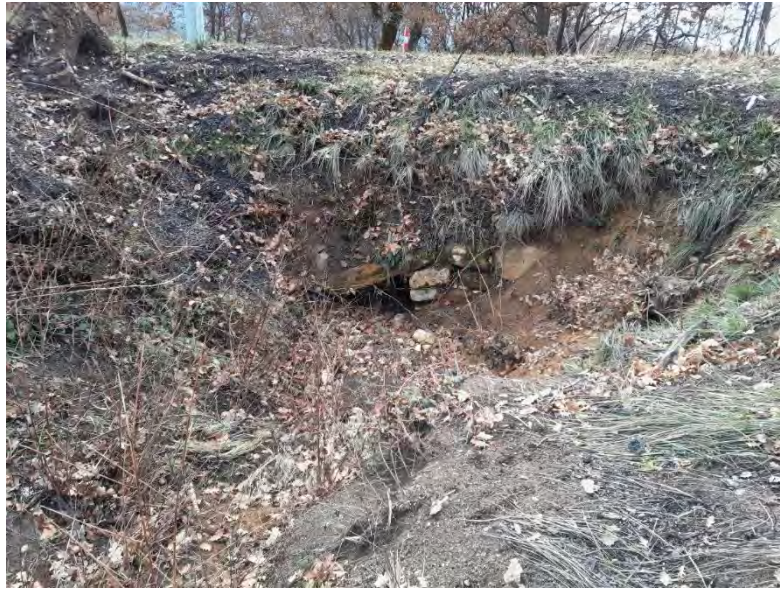
Figure 36 : vue de la tête amont de la traversée de chaussée (ravine 2)
