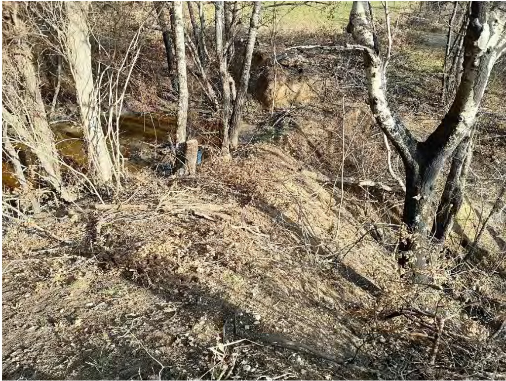
Figure 52 : retenue d'eau type barrage en terre
