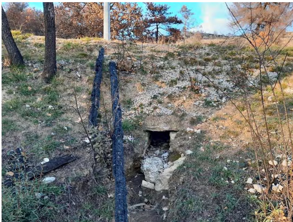
Figure 47 : vue de la tête aval de la traversée de chaussée (ravine 6)
