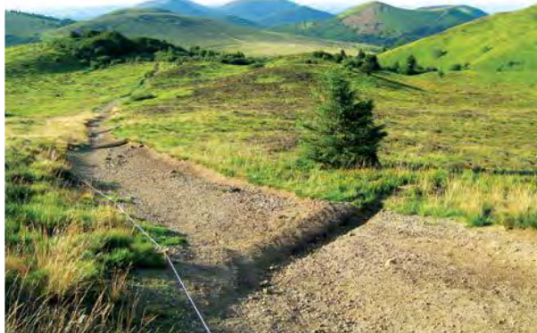
Illustration du renvoi d'eau en terrain naturel (PNR des Volcans d'Auvergne)
