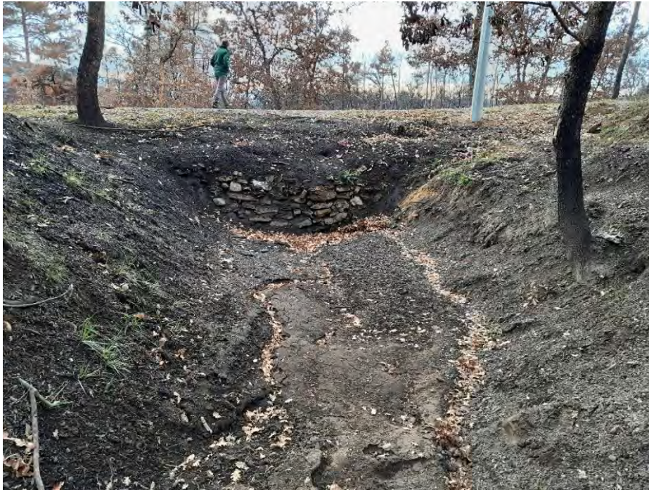
Figure 39 : vue de la tête amont de la traversée de chaussée (ravine 3)
