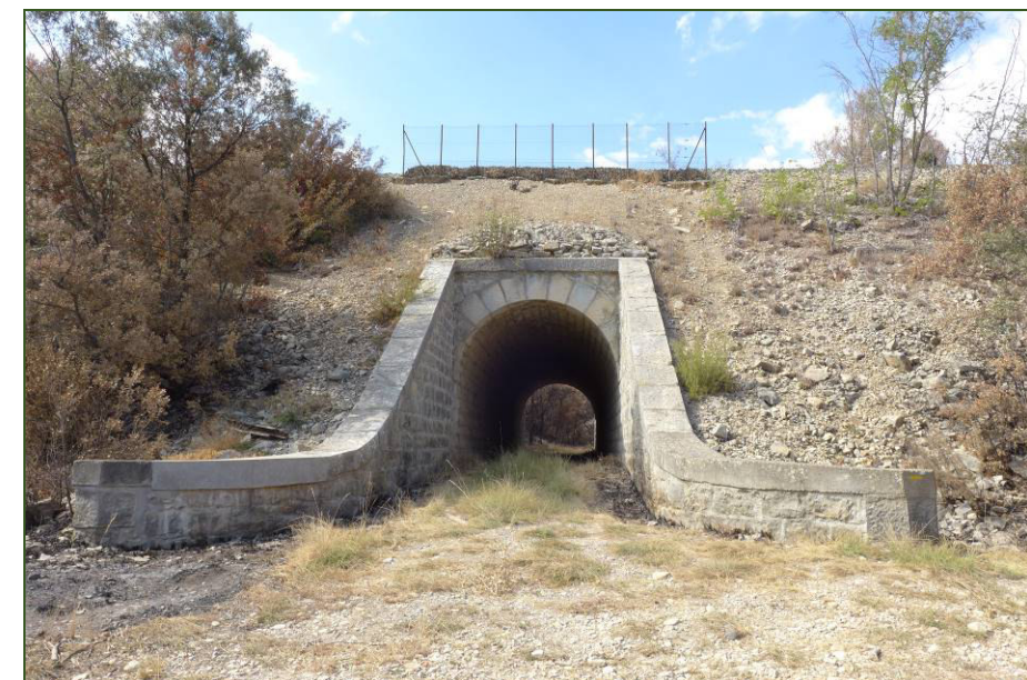
Ouvrage de franchissement sous la voie de chemin fer
