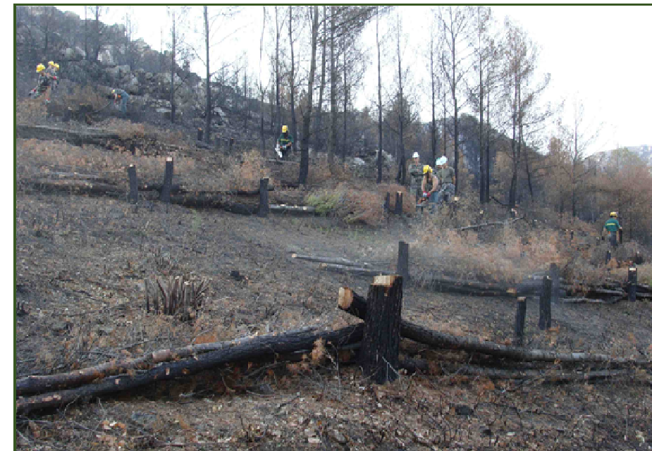
Travaux de mise en fascines (Marseille – 2009)
